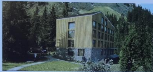
Das neue Berghotel Mettmen entsteht auf den Grundmauern des bestehenden Berggasthauses.
